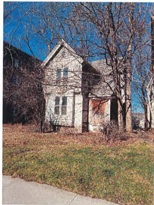
1311 E. GENESEE STREET
