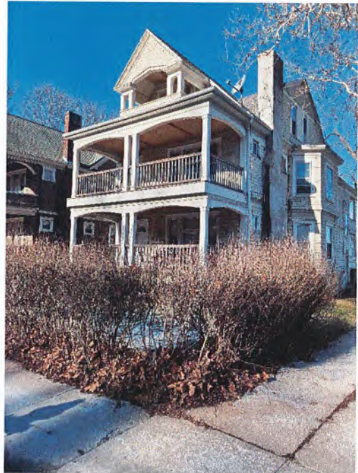
1323 E. GENESEE STREET
